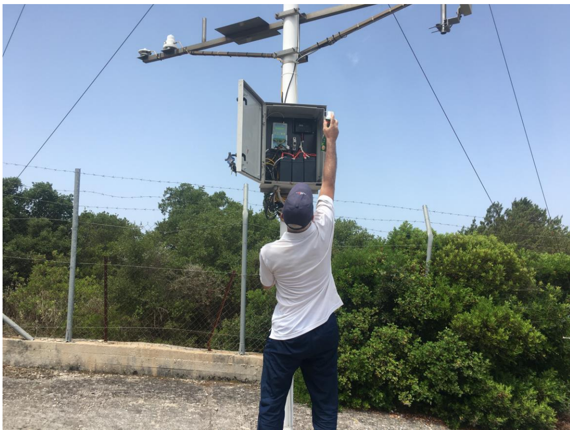
Εικόνα 1.2-5: Απο τις τεχνικές εργασίες στον σταθμό ΚΕΦ-1 στις 23/6/2022.
