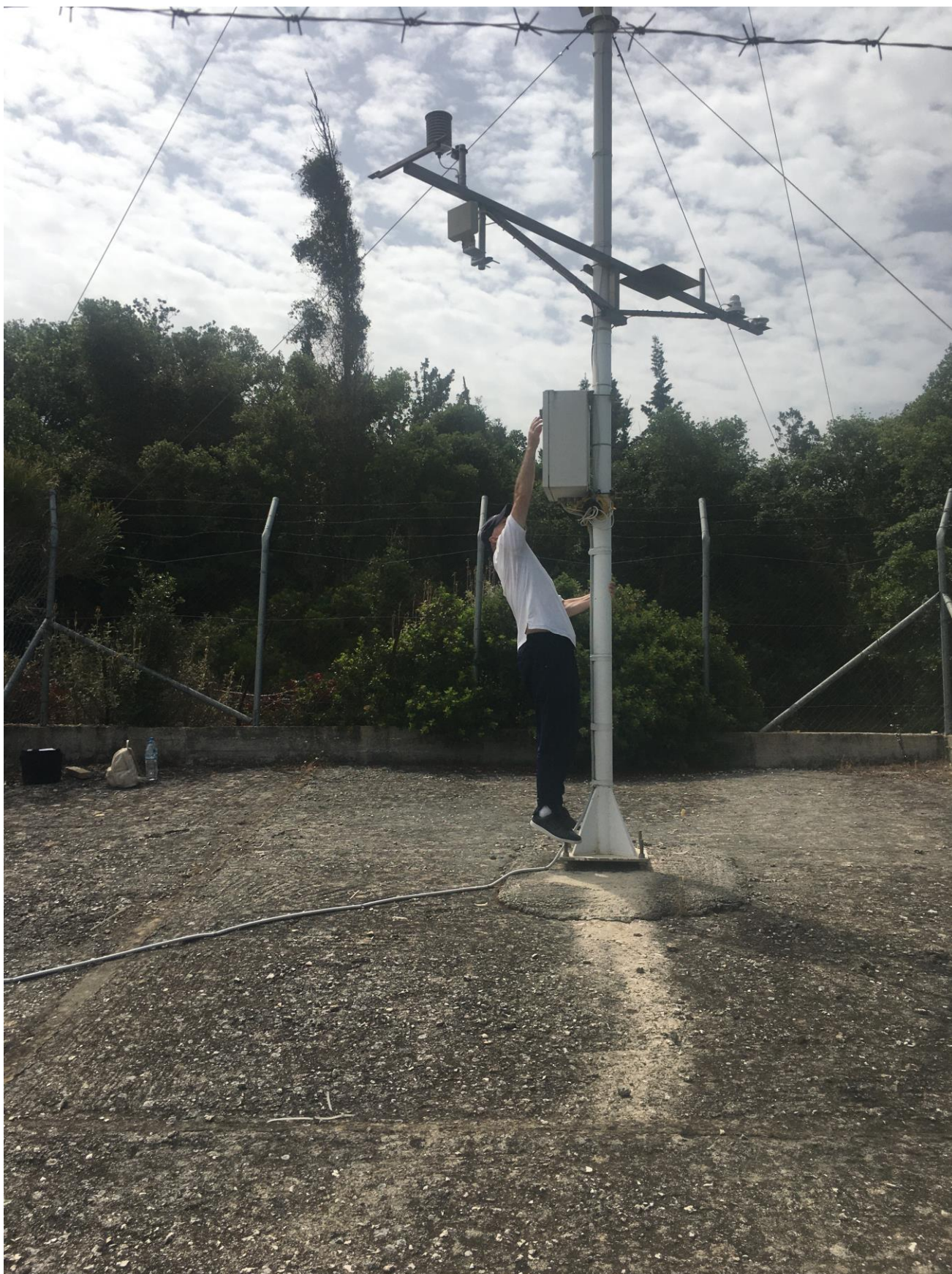
Εικόνα 1.2-2: Απο τις τεχνικές εργασίες στον σταθμό ΚΕΦ-1 στις 23/6/2022.
